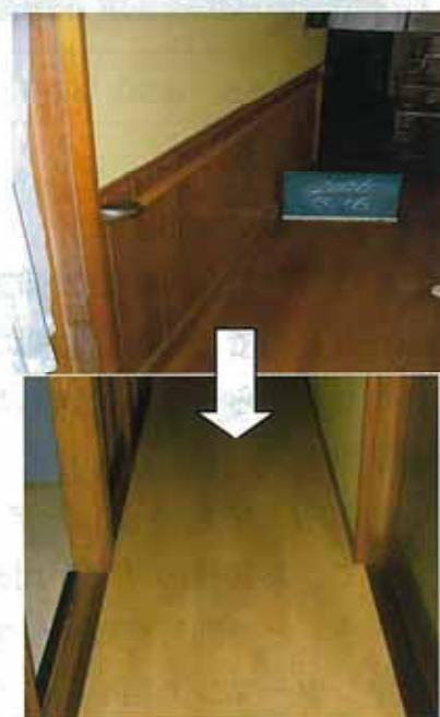
3cm廊下をかさ上げ 段差をなくしました
