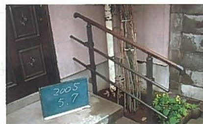
手すりを設置。昇り降りを楽に。
