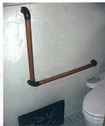
手すり取り付けの改修例
