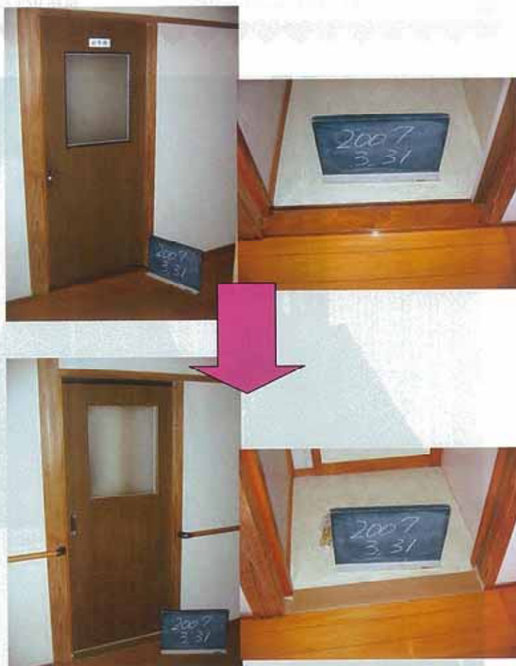
扉を吊下げ式にして敷居木を取り除きました
